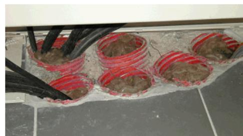
**Mise en œuvre d'une bande malléable d'étanchéité**      **Bourrage d'isolant dans les fourreaux + colmatage extérieures.**
