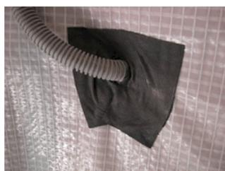
Mise en œuvre d'une bande malléable d'étanchéité au niveau de chaque traversée du pare vapeur par des gaines électriques (Exemple : Delta Flexx de chez Dorken)
